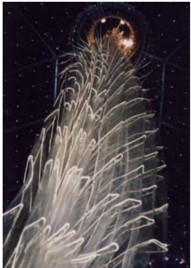
図 5. 検出器タンク内のバルーン据え付け作業
