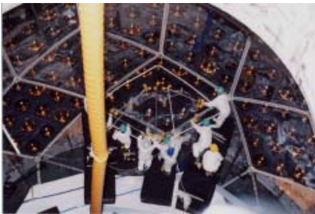
図 3. ラドン遮蔽用アクリル板の取り付け作業
