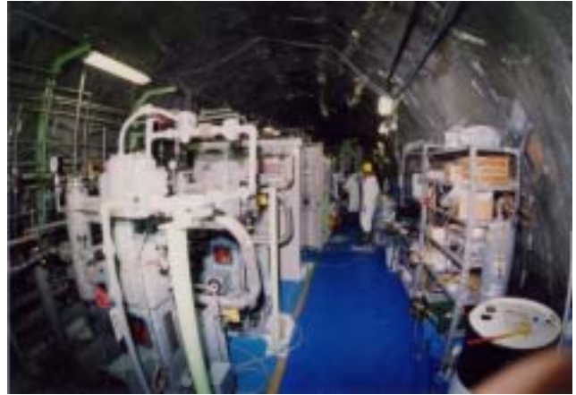
図7. 液入れ作業中の純化装置エリア
