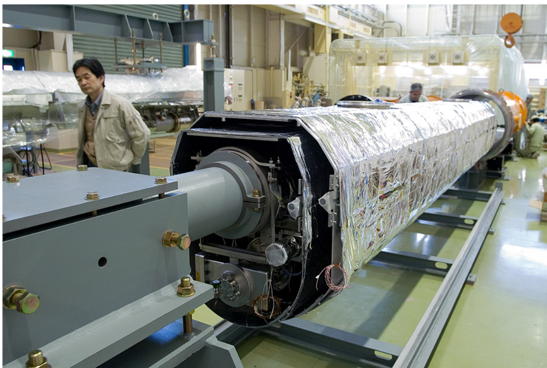
図9 STFにおいて組み立て中のクライオモジュール（空洞およびヘリウム配管系を断熱真空容器に挿入している様子）
