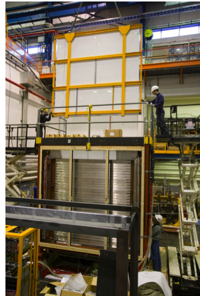
図 7: SciBar 検出器のシンチレータ組み立て作業の様子。
