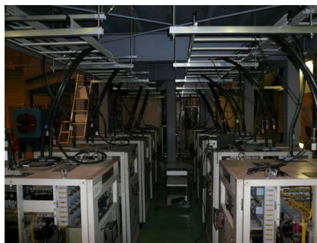
写真 4 ステージ下には 12 台のマグネット用電源が並ぶ
