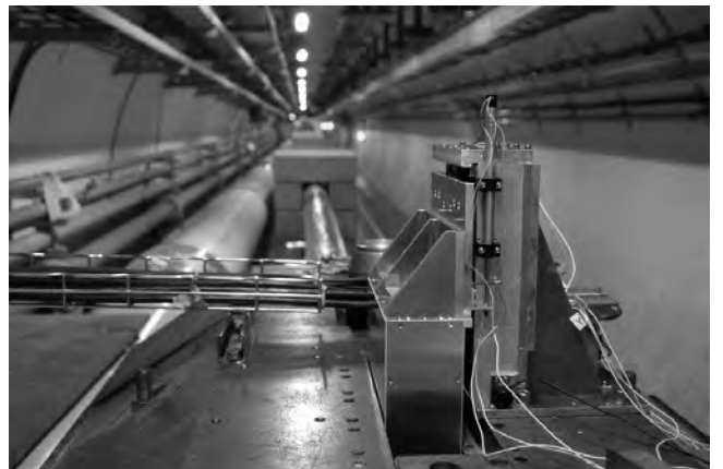
図 14: LHC トンネル内に設置された LHCf 検出器。
