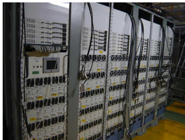
写真5：設置作業中の ATF2 用電磁石電源
