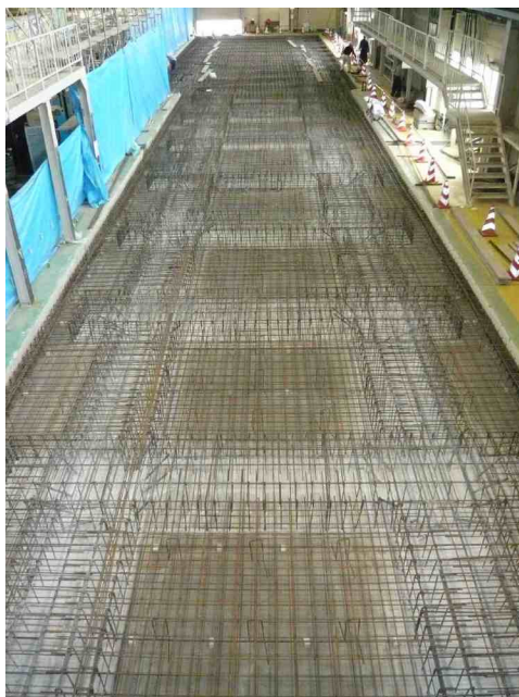
写真 1：ATF2 最終収束部の床補強工事
