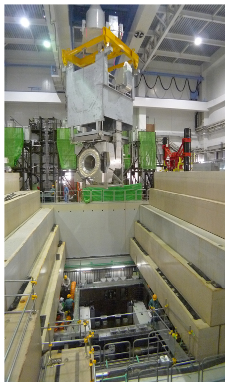
図 23 上部コンクリート遮蔽体と第三ホーン
