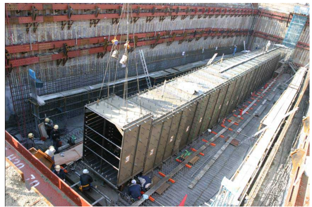
図24 建設中のディケイボリューム鋼製トンネル
