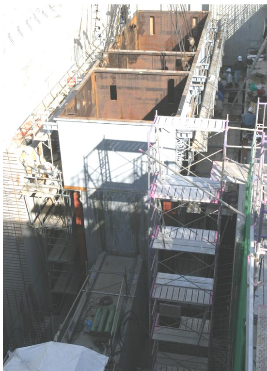
図 20 建設中のヘリウム容器
