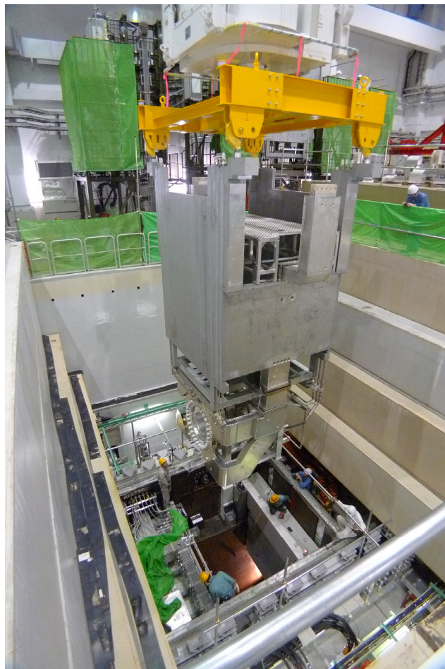
図13 ヘリウム容器に設置中の第二ホーン
