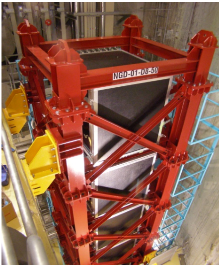
図 4-4 横型モジュール(上)と縦型モジュール(下)の写真 各立方体が1モジュールに対応している。
