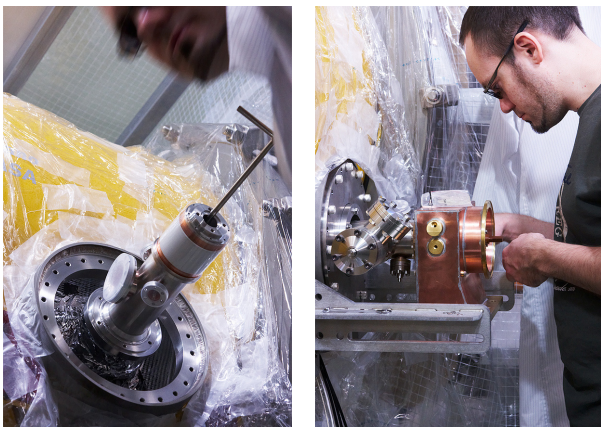
図 22 FNAL/DESY 空洞への室温部カップラーの取付け作業 (TTF-III インプットカップラー)
