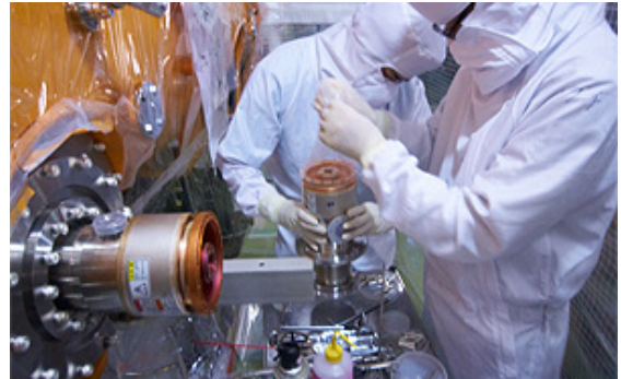
図 23 KEK 空洞への室温部カップラーの取付け作業 (STF-II インプットカップラー)
