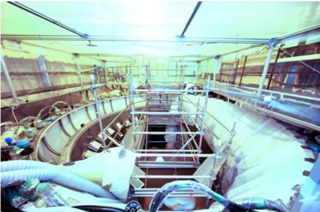
図6 ニュートリノ検出用光電子増倍管導入時のピット
