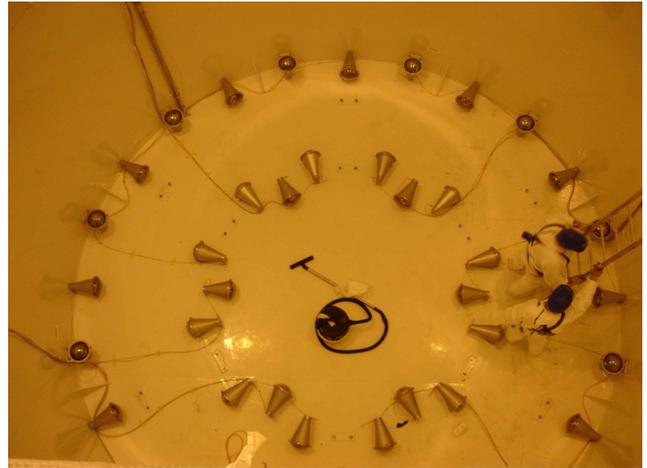
図 4 内部ミュオン検出器用光電子増倍管設置作業
