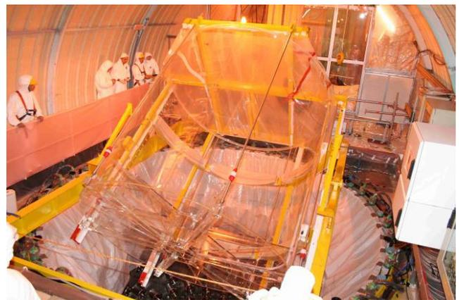
図9 ガンマ線捕獲層用アクリル容器導入
