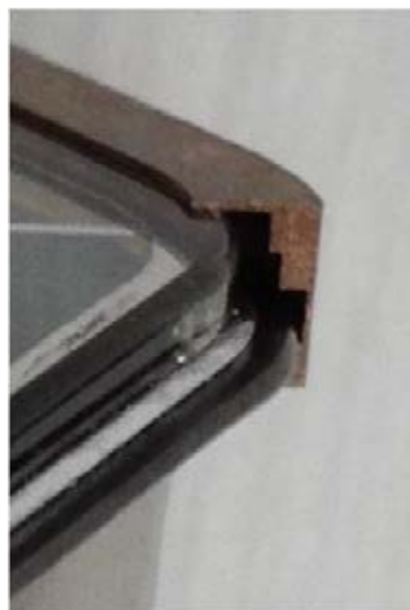
図 16: シール材のアルミニウムを覆うための銅製カバー。
