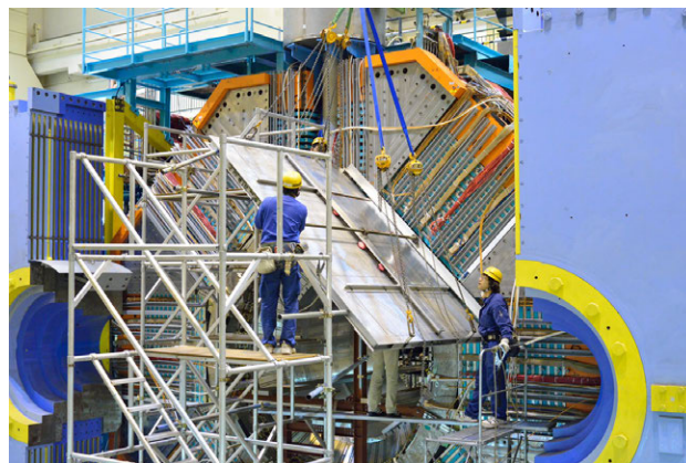
図 5: バレル KLM モジュールのインストール。
