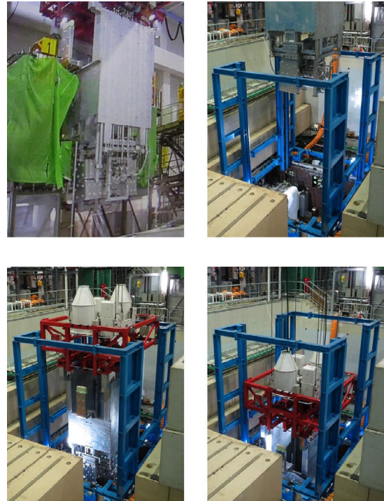
図10 電磁ホーンを設置
