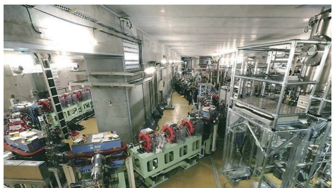
図 2: cERL 加速器室内部の写真 (第 2 アークと電子銃から主加速空洞を望む)
