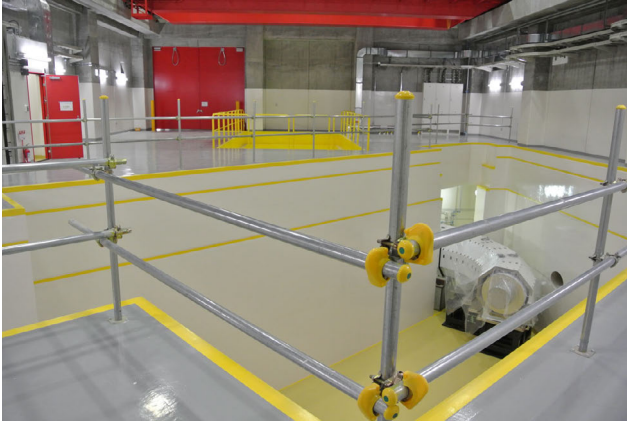
図 10: COMET 実験棟内の搬入ヤードの写真。手前の開口はビームライン室であり、 \mu 粒子輸送ソレノイド磁石が一部すでにインストールされている。陽子ビームは写真中の右奥側から入射される。
