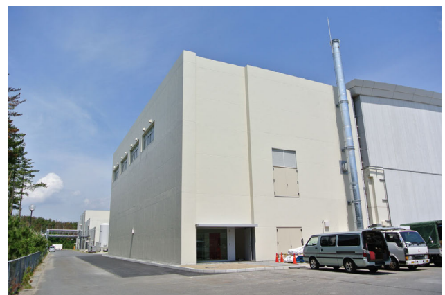
図 9: COMET 実験棟の外観の写真。写真中右側のCOMET 実験棟の隣の建物は既存のハドロン実験ホールである。ビームライン上流(メインリングのある方向)は写真中の奥方向である。
