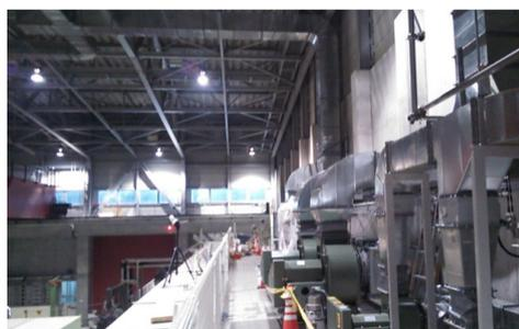
図 6: ホール内に設置された排気管理設備
