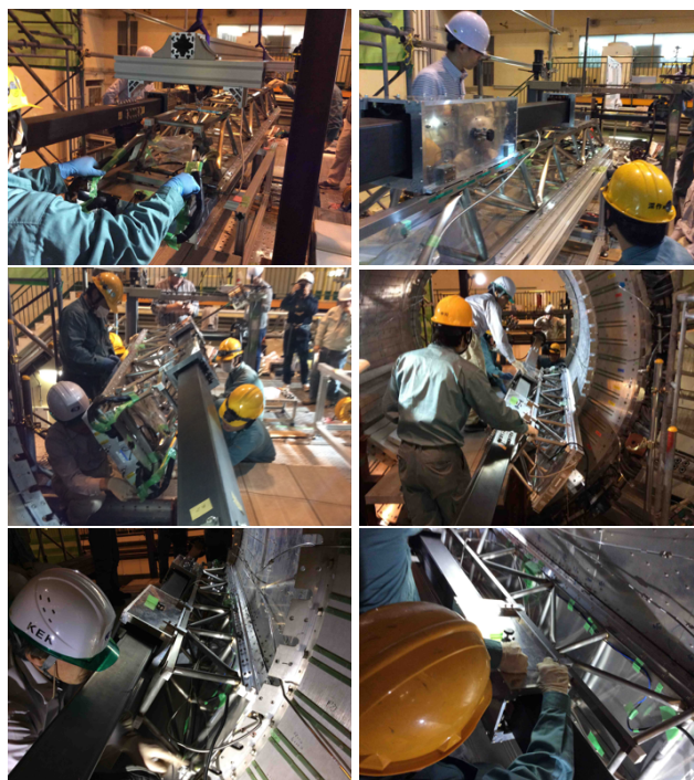
図 18: 実機 1 機目の据え付けの様子。詳細は本文に記載。
