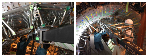
図 24: ストロングバックの取り外しの様子。詳細は本文に記載。
