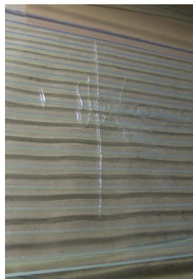
図 8: ファイバー張り付け後、発生したクラック。貼り付けより2ヶ月程度経過したもの
