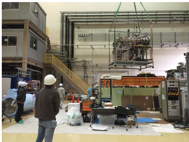
図4: 架台上のセットアップを吊り上げた際の様子。
