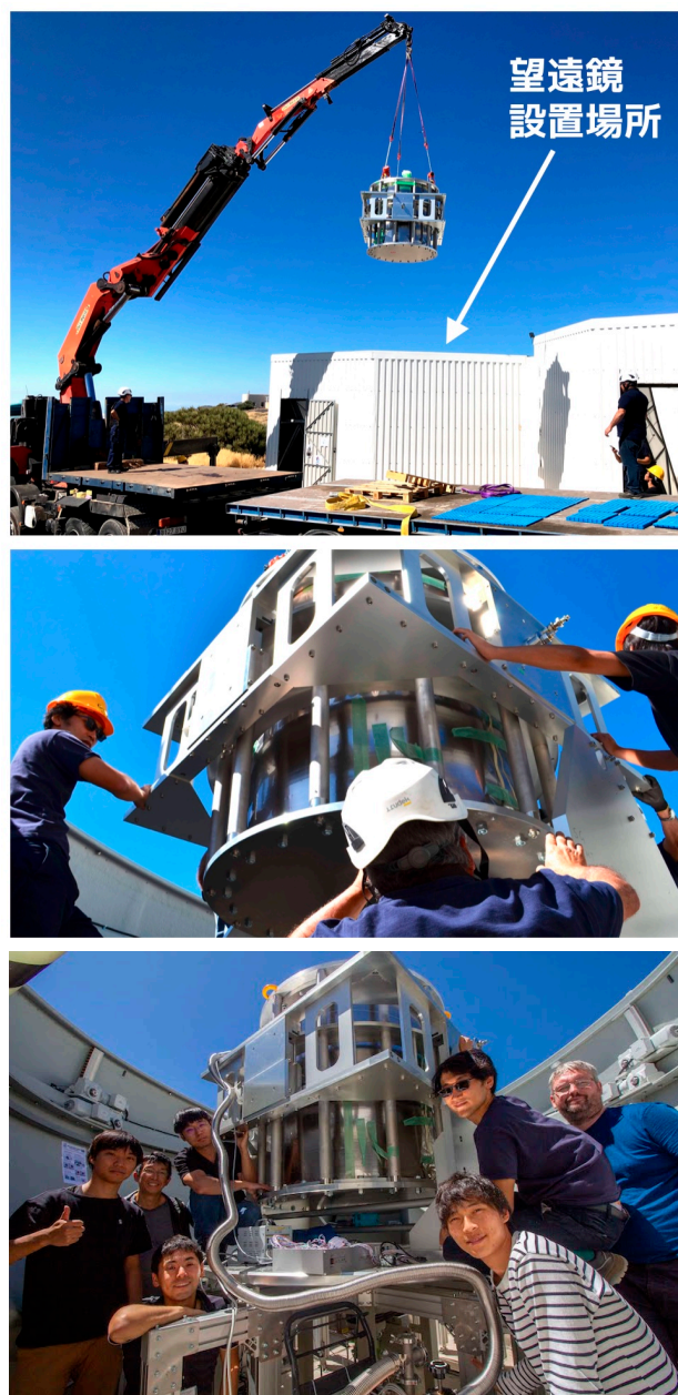
図 8: 望遠鏡の観測所インストールの様子。トラックに直接載せて観測所まで輸送し、クレーンで回転台の上に設置した。
