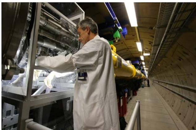
図15 DESY で建設中の Euro-XFEL のトンネル内におけるクライオモジュール連結作業の様子(DESY のウェブサイトより[22])。連結部全体を透明なケースで囲い、下部からクリーンエアを流し、パーティクルカウンターで作業中のパーティクル数をモニターしながら作業を行う。作業者の手が入るところのみ開放されている。連結部は加速器全体でおおよそ100箇所になる。
