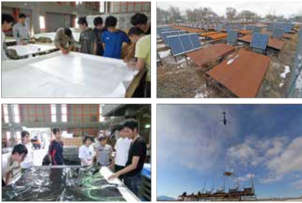
図 6: テレスコープアレイ実験の地表粒子検出器アレイの建設および設置の様子 (画像提供: Telescope Array Collaboration/ICRR PR Office)。
