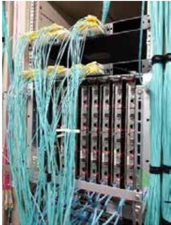
図 6 FEE からの光ファイバーを COPPER ボードからその上に設置された PCIe40 へつながるパッチパネルに挿し直したところ。
