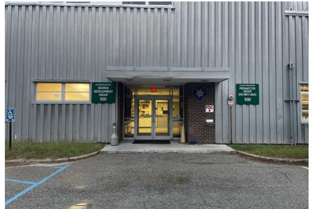
約3か月間お世話になった 930 Building
